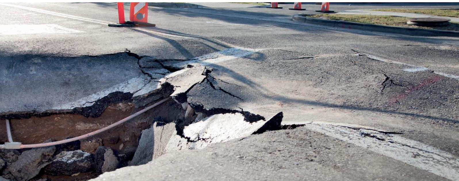
Les pertes physiques au sein d'une DMA résultent de fuites tant dans les canalisations principales que sur les raccordements domestiques. La fuite apparaît en cas de trous ou de fissures dans les canalisations ou de vannes défectueuses.
