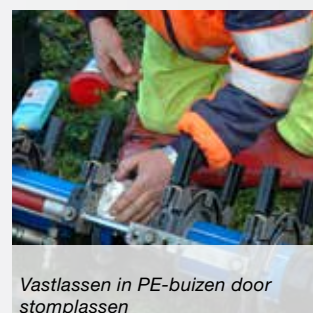
Het lassen van PE-buizen door middel van lasmoffen
